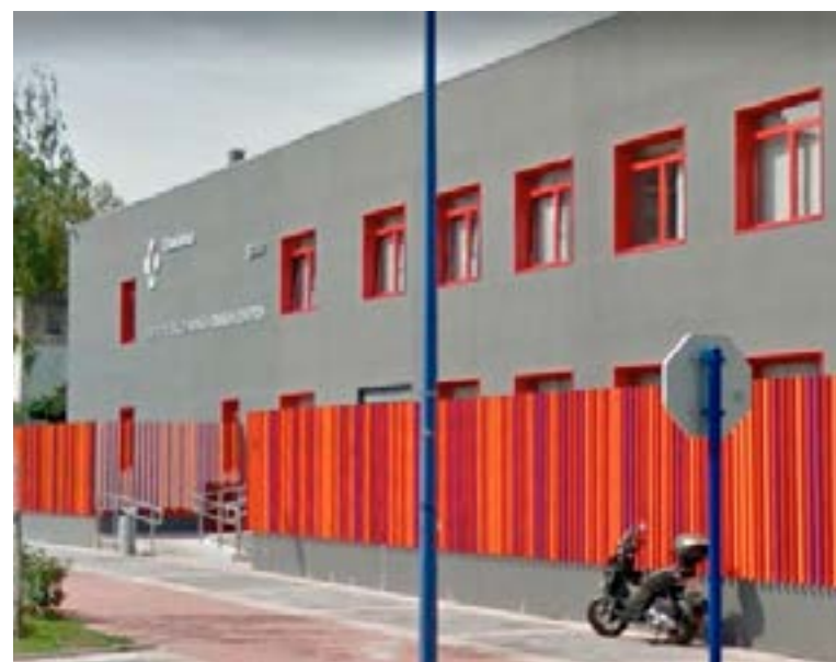
Fachada del PAC de Mungia, en Bizkaia
