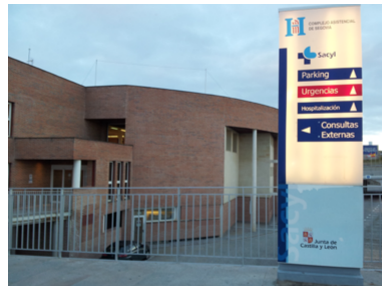
Fachada del Hospital de Segovia
