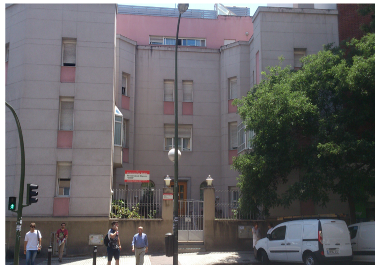
Las residencias de mayores sufren múltiples deficiencias y problemas
