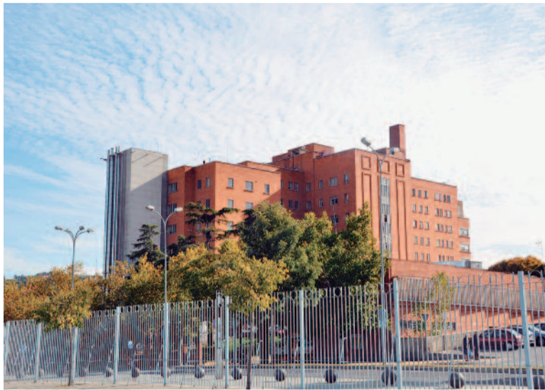
Fachada del Hospital San Pedro de Alcántara, en Cáceres
