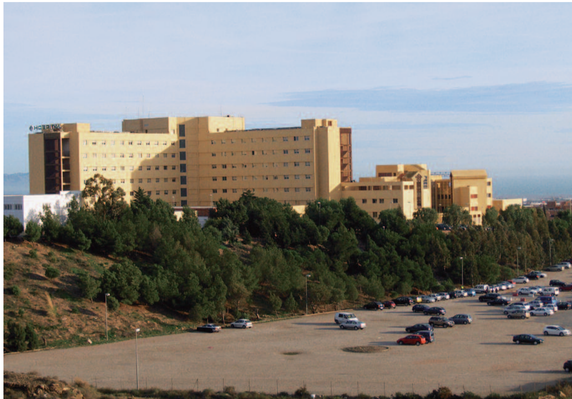
Fachada del Hospital Torrecárdenas, en Almería
